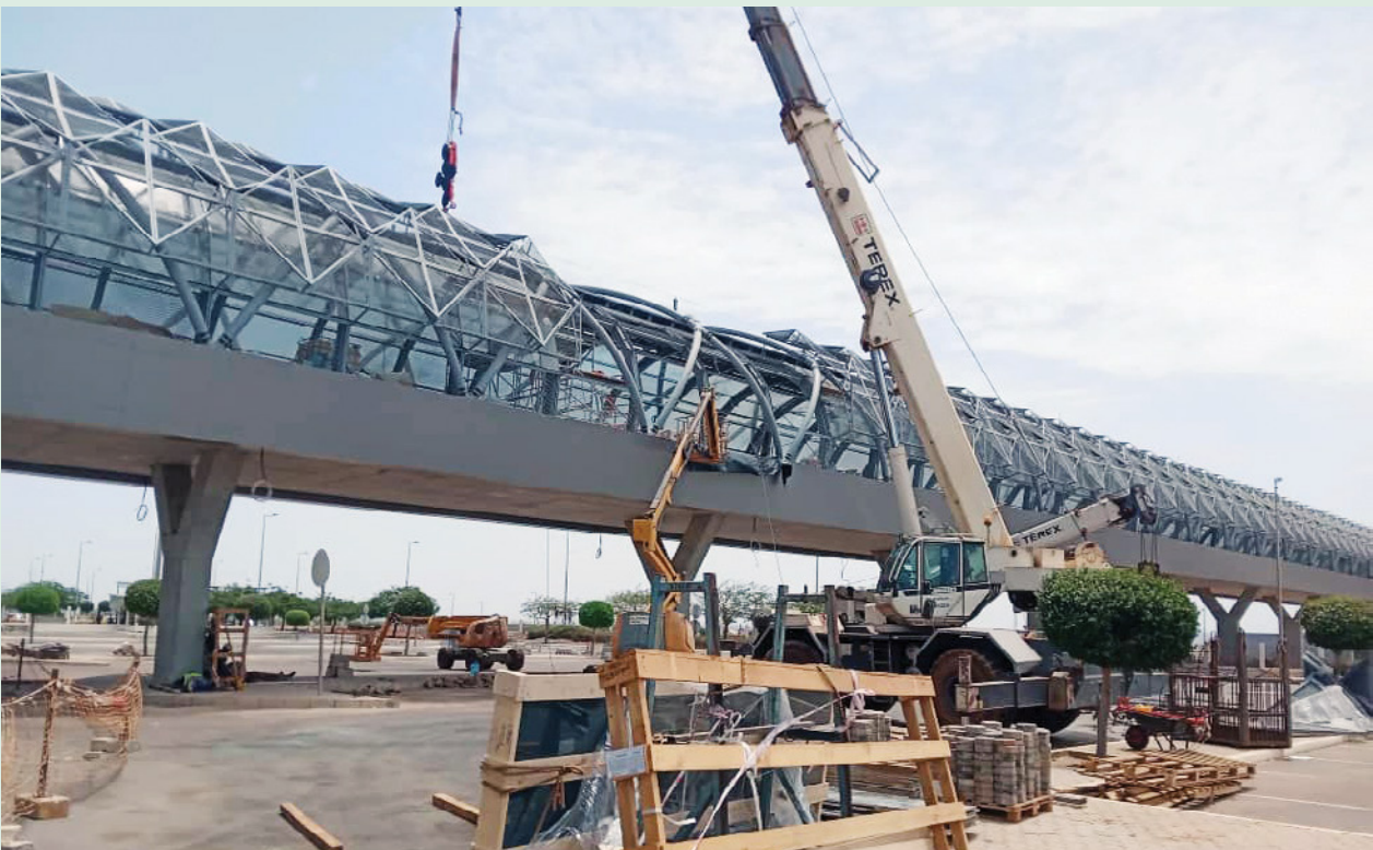
Pont TER-Aéroport, Sénégal
